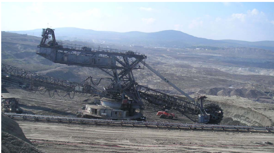
Slika 5. Slika – Eskavator iskopavanja u EKK
