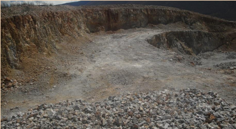
Figura 15 Fillimi i ndërtimit një shkalle punuese minerare
