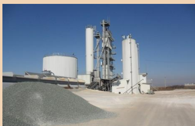
Figura 6 Impianti për përgaditjen e Asfaltit
