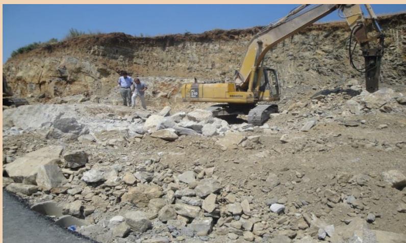
Figura 28 Dëmtim i ambientit dhe rrezikim i shkallëve përfundimtare si shfrytëzim pa kriter
