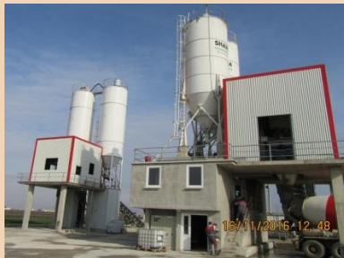
Figura 5 Impianti i Betonit
