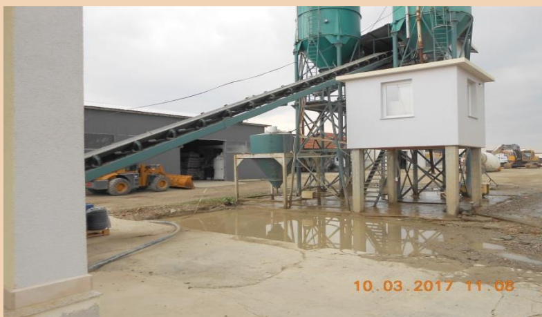
Figura 30 Aktiviteti ilegal i bazës së betonit dhe shfrytëzimi i resursit të përpunuar nga seperacionet
