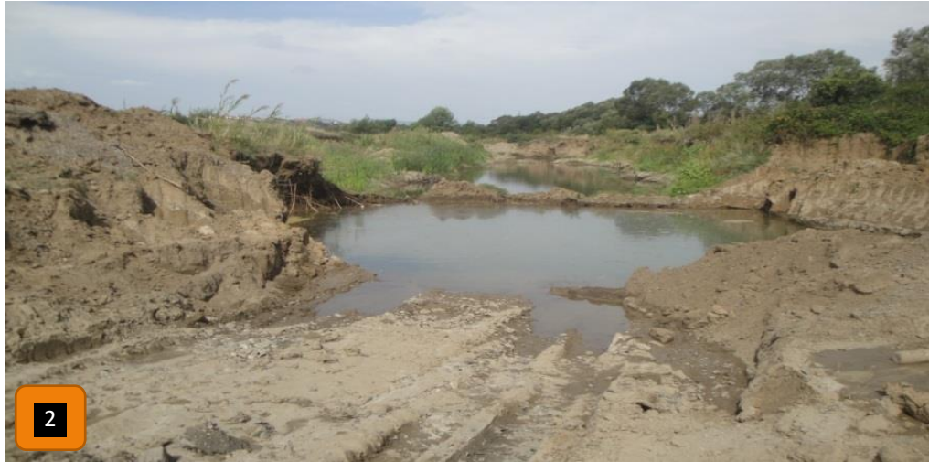
Figura 72 Deponi uji nga shfrytëzimi i argjilave dhe rërave, pellgje degraduese dhe rrezik për njerëz – Insp. Komunal
