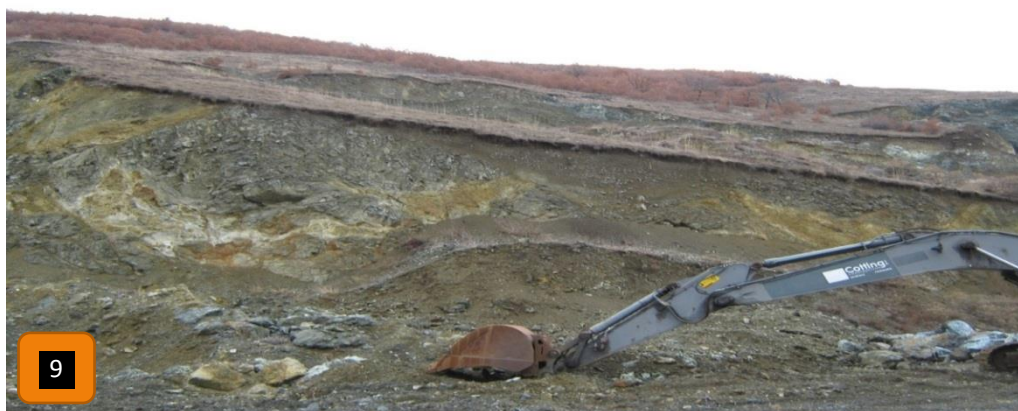
Shumë afër liqenit të Badovcit. Foto 9 degradim i shtresës humusore –barishte.
