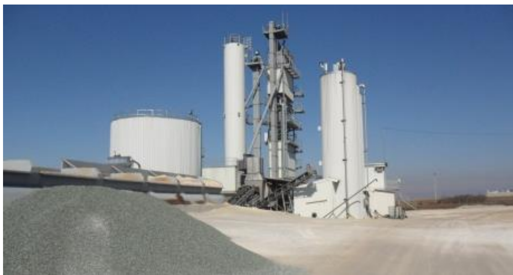
Figura 6 Impianti për përgatitjen e Asfaltit - KPM
