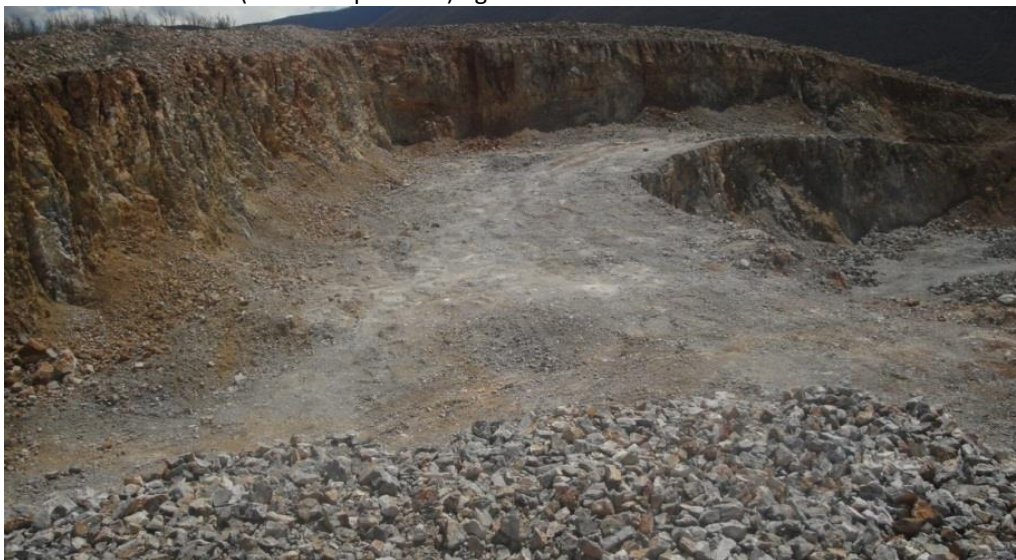
Figura 63 Fillimi i ndërtimit një shkalle punuese minerare
