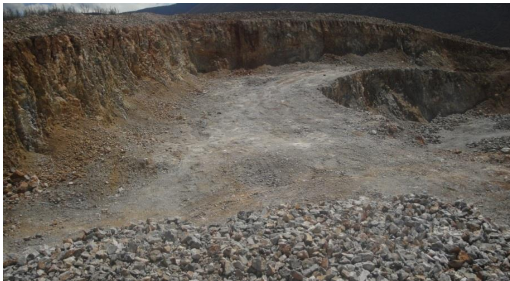
Figura 15 Fillimi i ndërtimit një shkalle punuese minerare - KPMM
