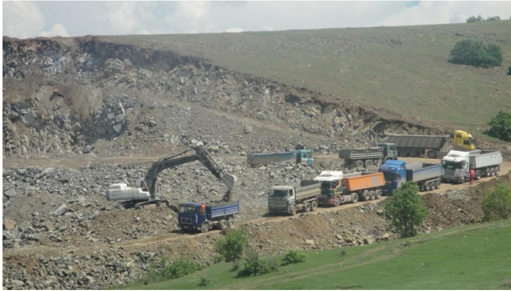
Figura 60 Uklanjanje poklopca kao pripreme faze za početak rudarskih operacija
