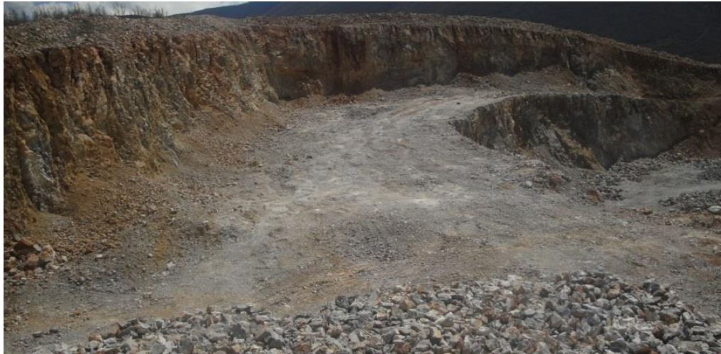
Figura 38 Početak izgradnje jedne rudarske stepenice - MSPP
