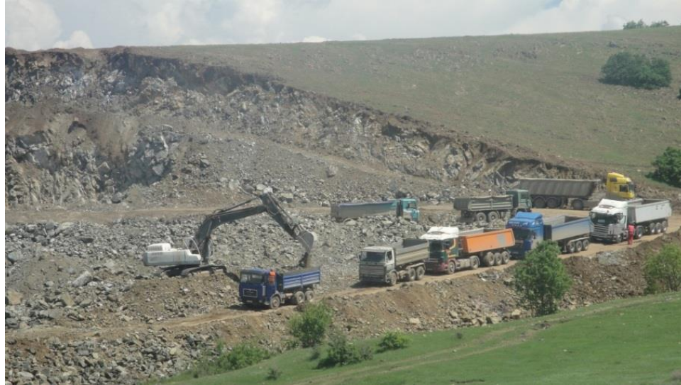
Figura 12 Uklanjanje pokrova kao pripreme faze početka rudarskih radova - NKRM
