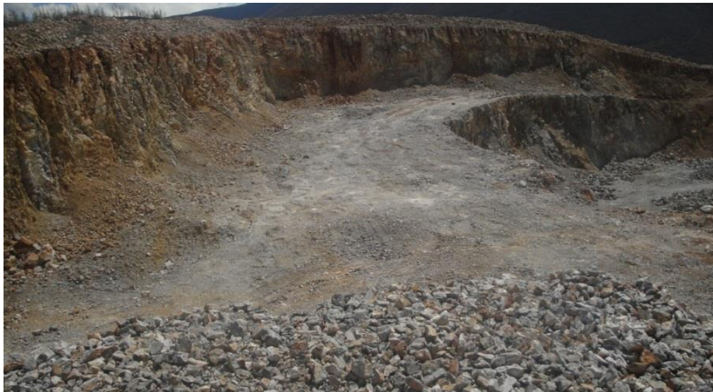
Figura 63 Pocetak izgradnje rudarske radne stepenice
