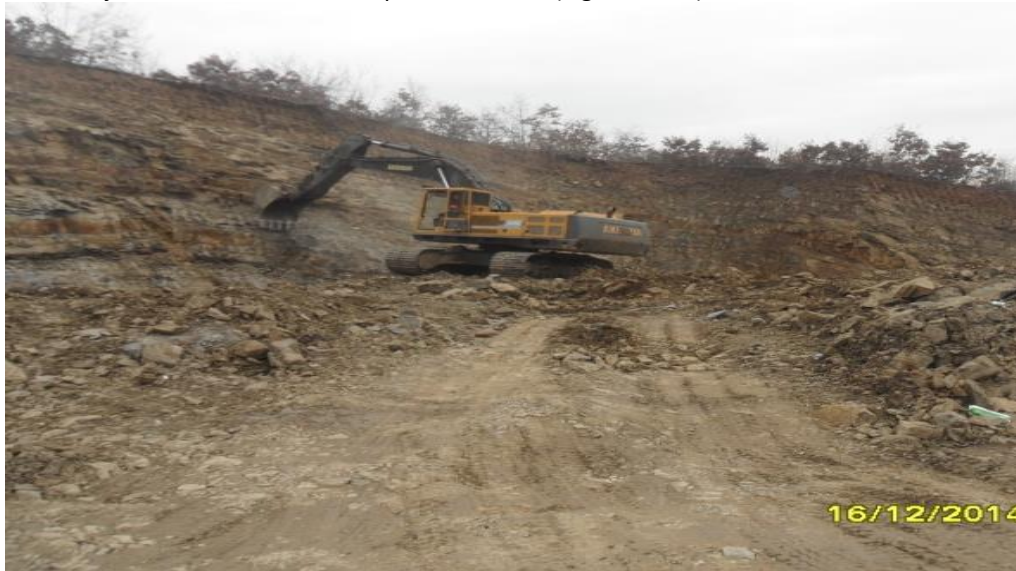
Figura 26 Eksploatacija bez kriterijuma, stvaranje visine skala i nedostaka ponovne kultivacije - NKRM
