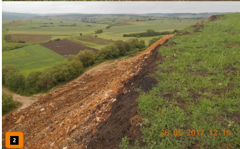
Figura 17 Re-kultivacija stepenica rudnika sa re-kultivacijom - NKRM
