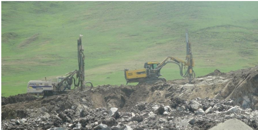
Figura 36 Aktivnost pripremljena za miniranje - MSPP.
