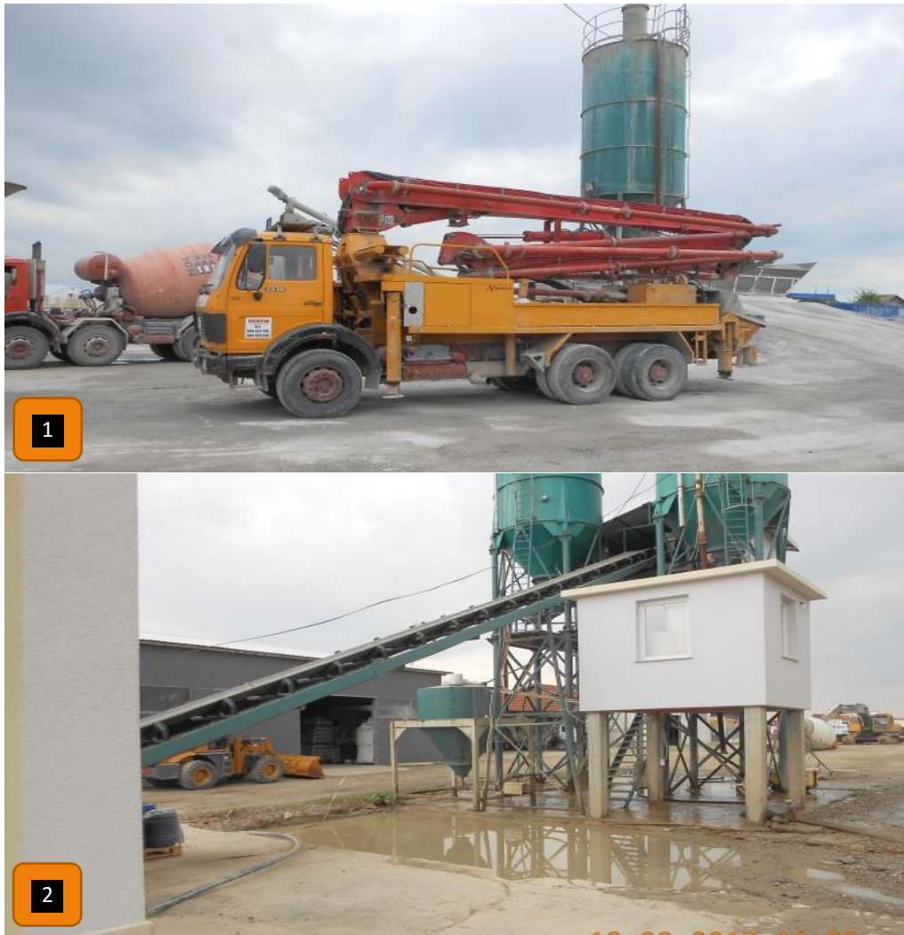
Figura 30 Ilegalna aktivnost betonske osnove i eksploatacija obradenog od separacija - NKRM
