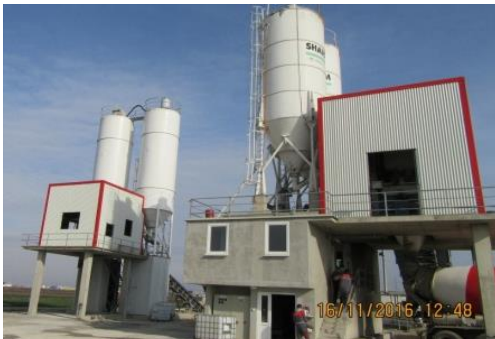
Figura 5 Postrojenje Betona Impianti i Betonit- NKRM
