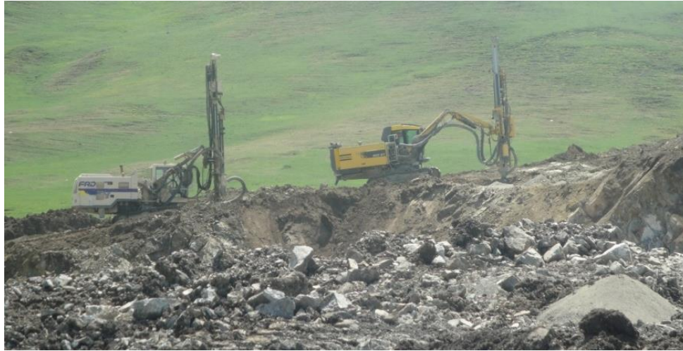
Figura 13 Aktivnost pripremanja oblasti za miniranje - NKRM.
