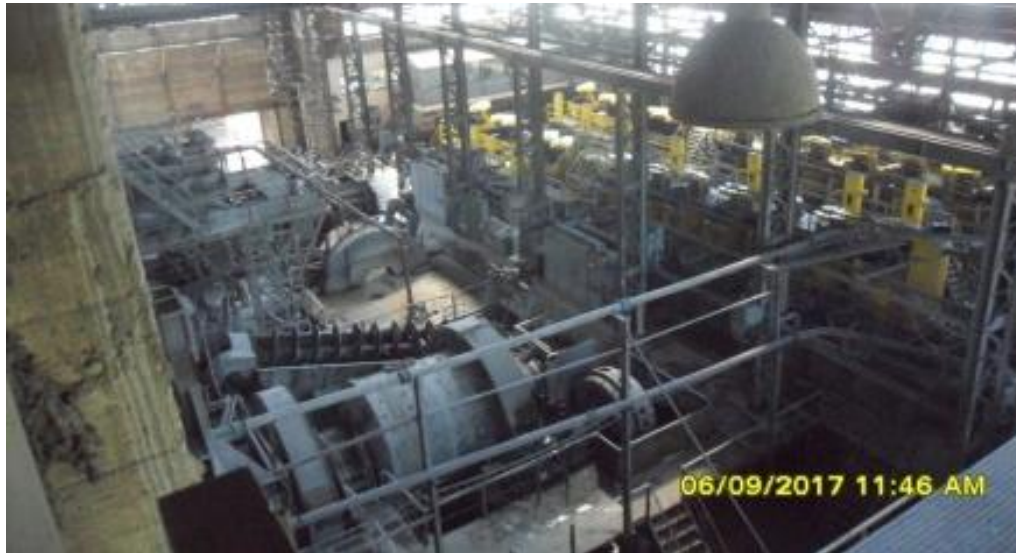
Figura 7 Postrojenje obogaćivanja minerala - Flotacija - NKRM
