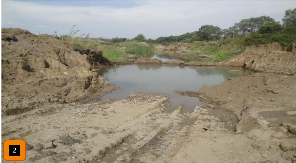
Figura 47 Rezervoar za vodu od upotrebe gline i peska, degradirajuci bazeni i opasnost za ljude - MSPP
