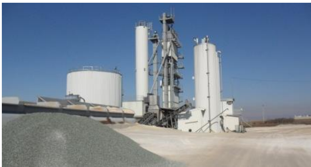
Figura 6 Postrojenje za pripremanje Asfalta - NKRM
