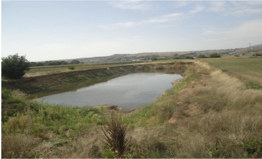
Figura 71 Stvaranje deponije vodom i oštećivanje granica okolnih polja - Insp. opštinski
