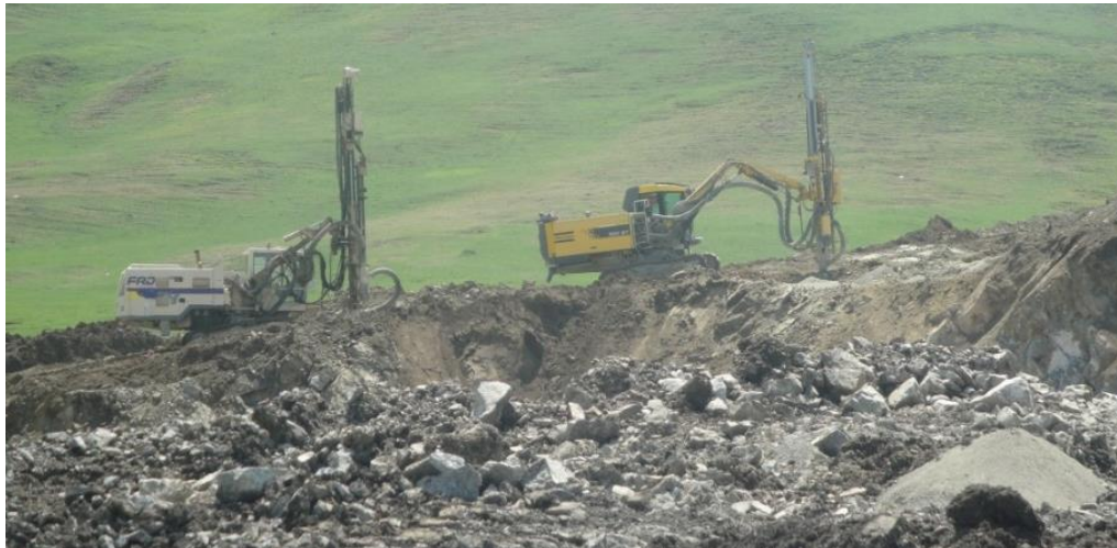
Figura 61 Aktivnost pripreme terena za miniranje.
