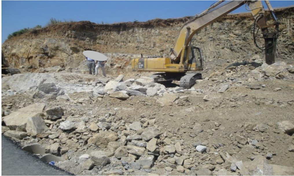
Figura 76. Oštećenje životne sredine i ugrožavanje krajnjih stepenica kao neselektivna upotreba - Insp. Opštinski
