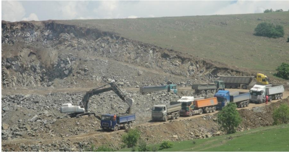
Figura 35 Uklanjanje površinskog sloja kao pripremne faze za početak rudarskih radova – MSPP
